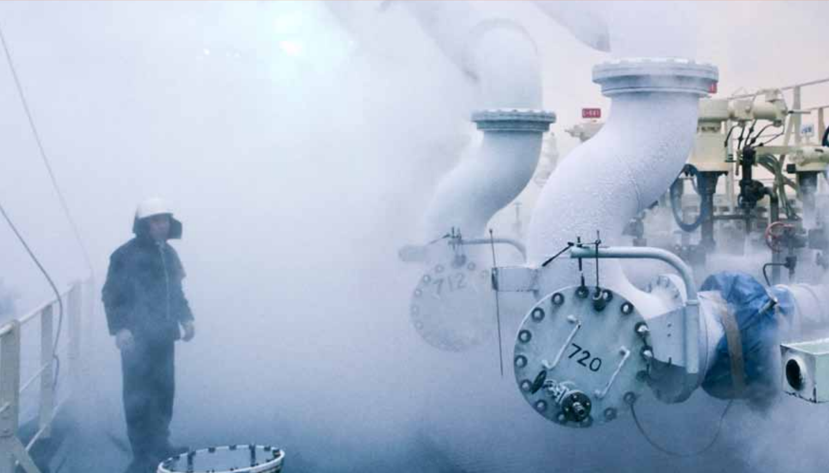
Eine Sicherheitskontrolle auf einer Erdgasbohranlage. Bis zu 90 Prozent der Offshore-Unfälle werden durch menschliche Faktoren verursacht.
