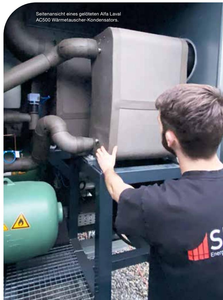
Seitenansicht eines gelöteten Alfa Laval AC500 Wärmetauscher-Kondensators.
