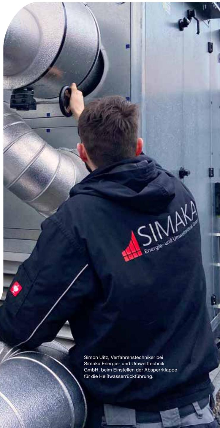
Simon Uitz, Verfahrenstechniker bei Simaka Energie- und Umwelttechnik GmbH, beim Einstellen der Absperrklappe für die Heißwasserrückführung.
