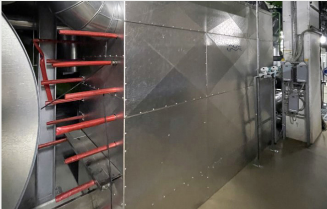
Verdampfer: Semi-verschweißter Plattenwärmetauscher MA30W
