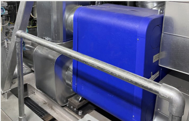
Kondensator und Unterkühler: Gelöteter Plattenwärmetauscher CBH410
