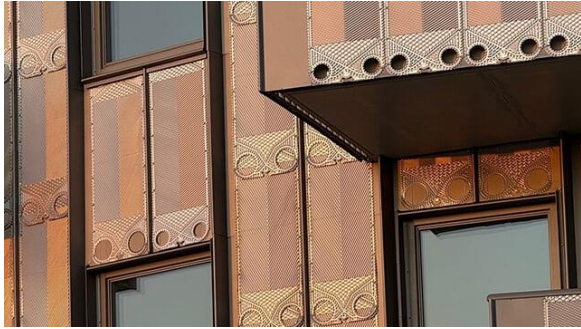
Bilder: Wohnhaus „Droppen“ in Malmö, Schweden, mit einer Fassade aus recycelten Wärmetauscherplatten von Alfa Laval. Copyright: Wingårdhs
