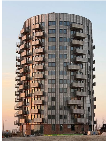
Bilder: Wohnhaus „Droppen“ in Malmö, Schweden, mit einer Fassade aus recycelten Wärmetauscherplatten von Alfa Laval. Copyright: Wingårdhs
